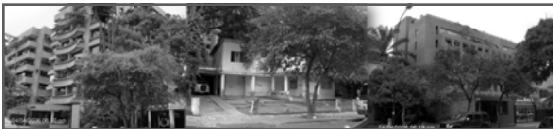
Figura N° 6.- Vista de la quinta Las Guaycas enclavada entre los edificios vecinos.
